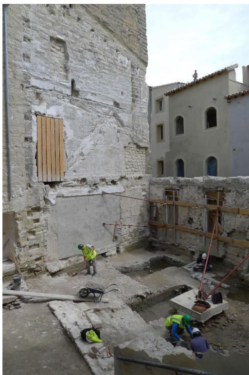
état de la façade sud de la tour. © Direction du Patrimoine
