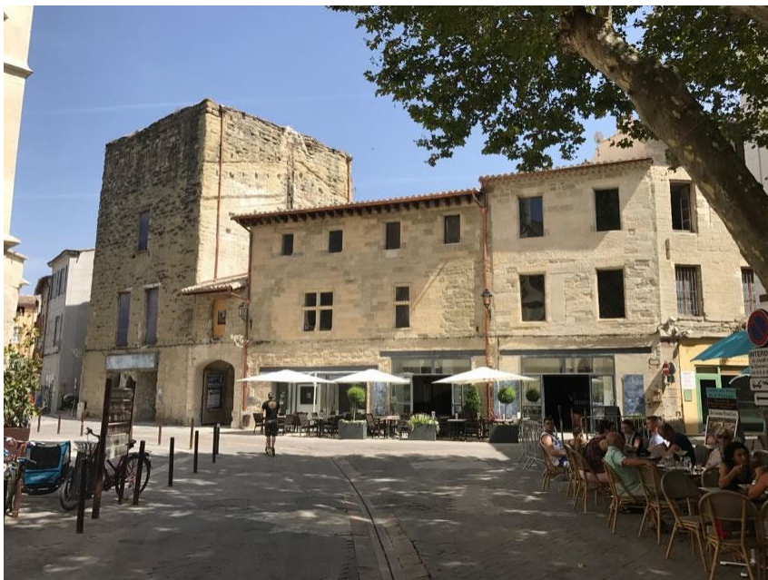
état actuel du bâtiment résidentiel (après restauration des volumes et de la partie supérieure des façades) et de la Tour © Direction du Patrimoine
