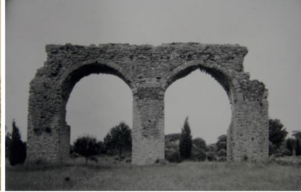
Arches 4 du château Aurélien après restauration de J. Formigé, © Auteur inconnu, 1939 – Médiathèque du Patrimoine
