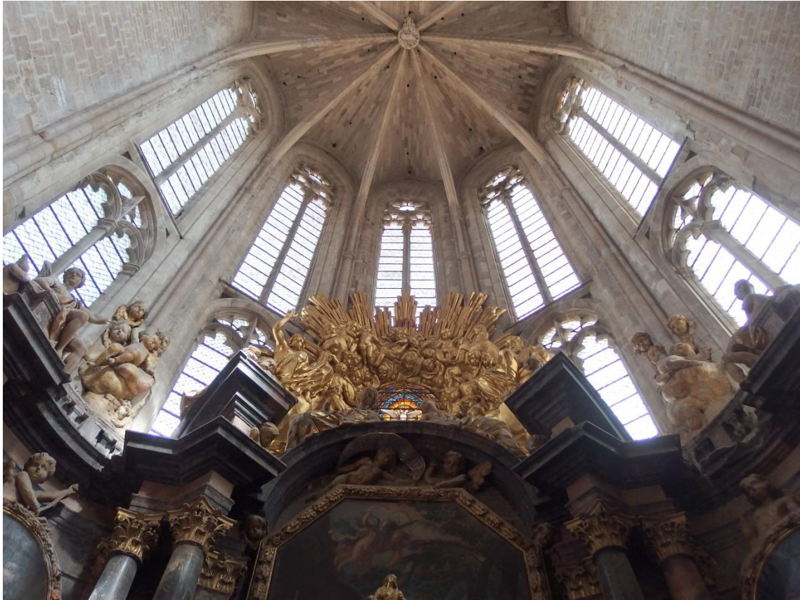
Saint-Maximin - chœur baroque et la voûte gothique. Cl. Pierrick Rodriguez, Drac/crmh Paca
