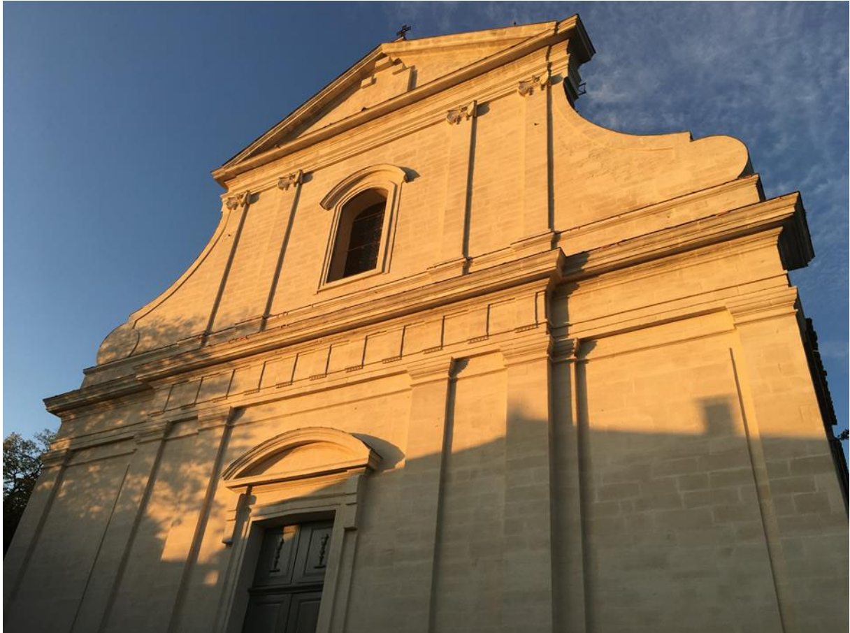
Eglise Saint-Pierre de Bédoin @ Fabrica Traceorum
